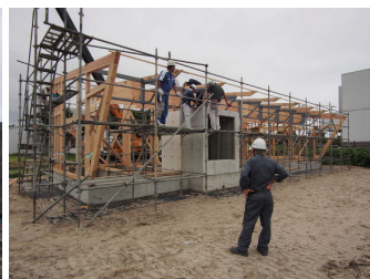
松本家具製作の木製トラス梁柱（梁の断面寸法は62×700、L字に曲げて柱と一体形成）
