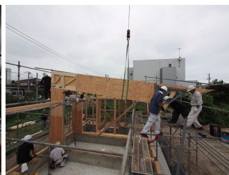
松本家具製作の木製トラス梁柱（梁の断面寸法は62×700、L字に曲げて柱と一体形成）
